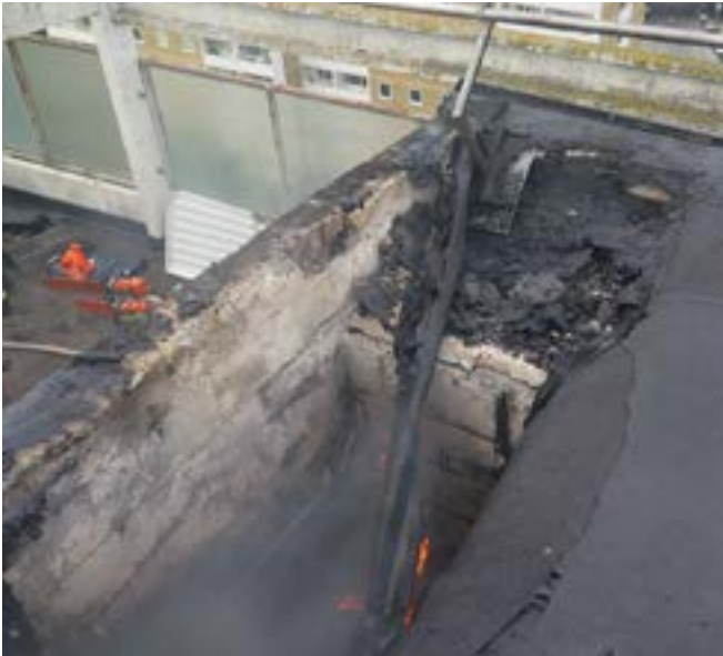
Det krävdes omfattande friläggning av papp för att komma åt branden som spridit sig till takkonstruktionen och även ett större vindsförråd.
