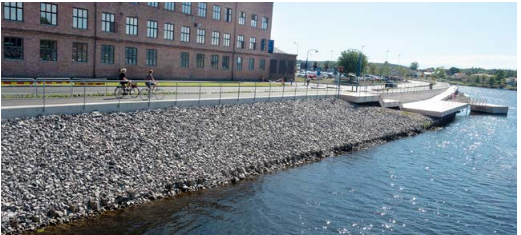
Översvämningsrisker har alltid funnits i Karlstad. Nu har kommunen och landstinget byggt en kombinerad skyddsvall och cykelbana som skyddar centralsjukhuset mot översvämningar motsvarande 10 000-årsflöde.
