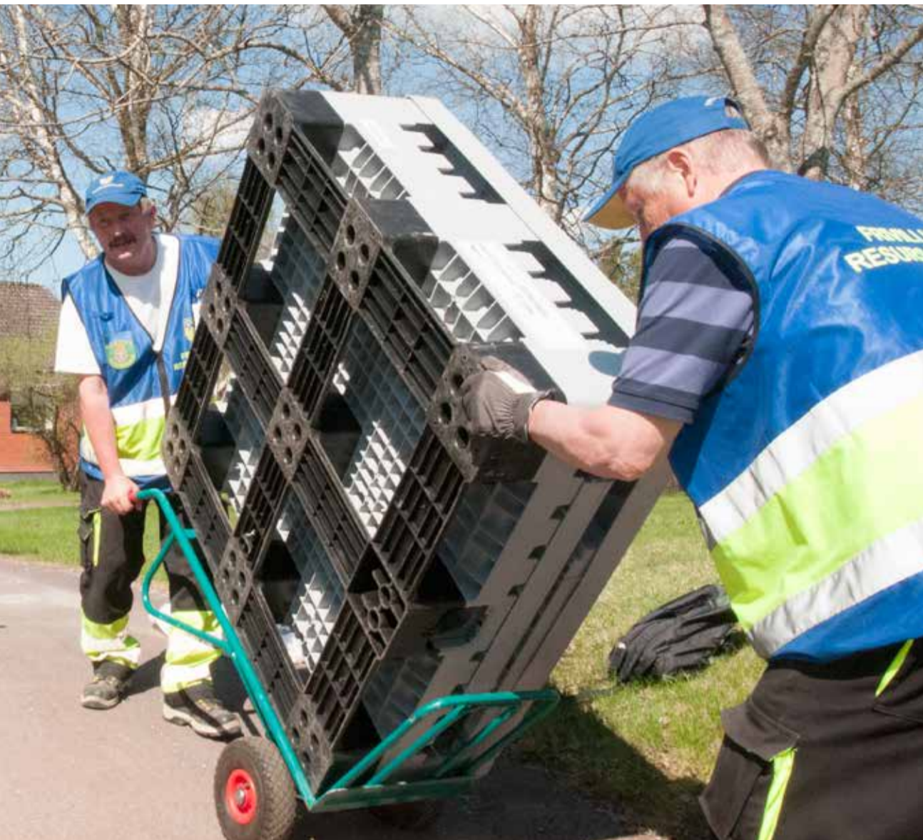
vattnet på Lyssfallets äldreboende i Enviken. Den hopfällbara vattentanken får plats i skåpbilen och flyttas på säckkärra. Pump med byggnadens vattenledning och för att vid behov koppla på mer inkommande vatten.
