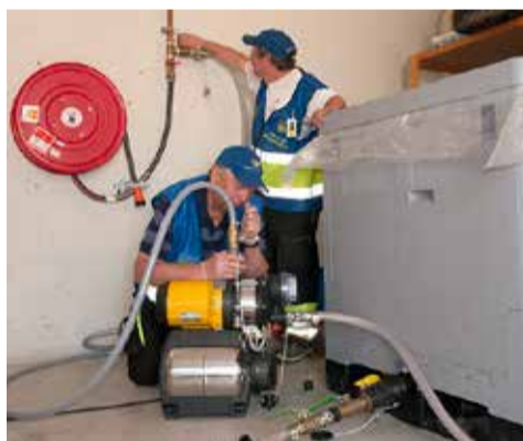
Vatten kopplas in på äldreboende av FRG. Pump och tank på 1 060 liter kopplas samman med byggnadens vattenledningssystem.
