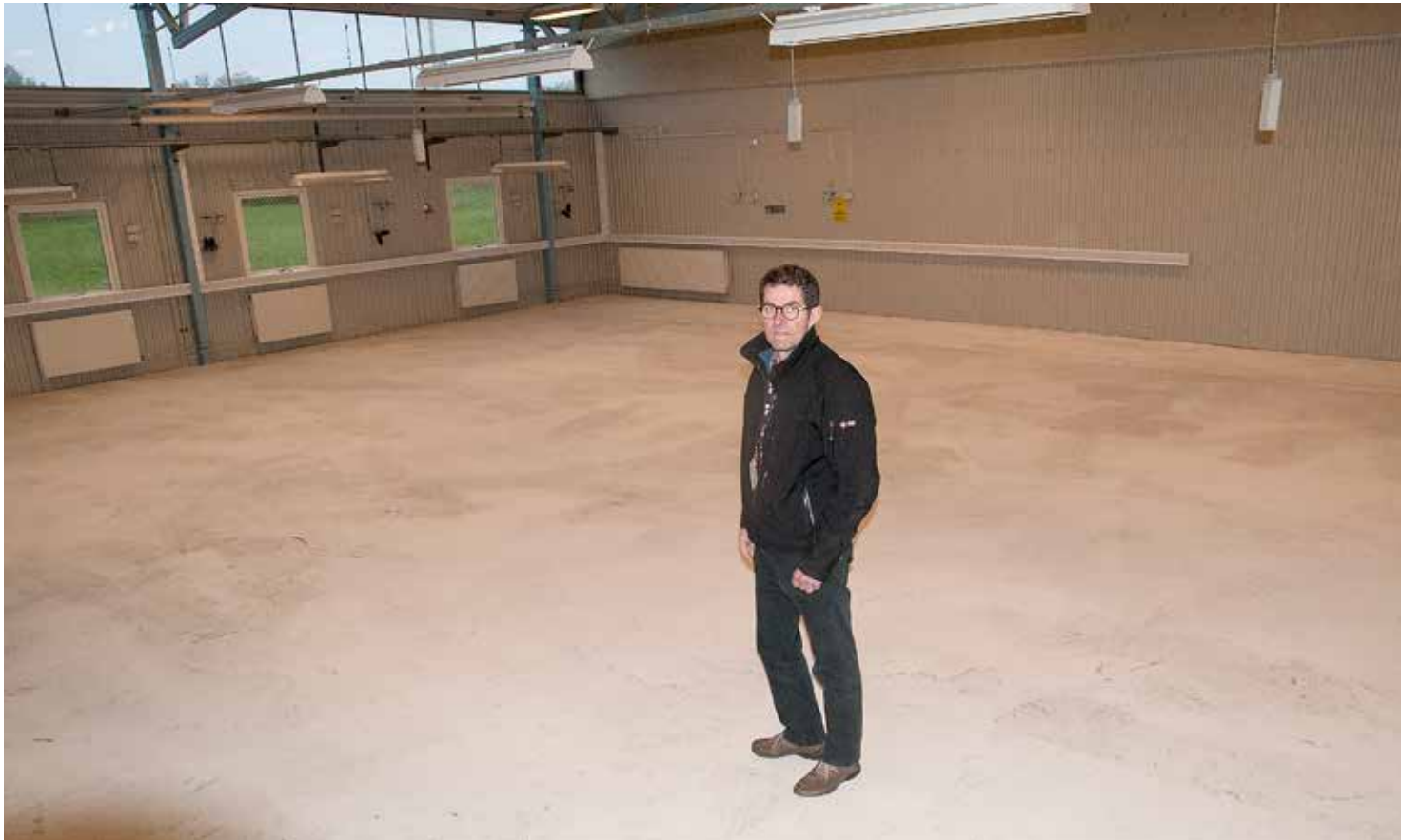
Här ska utbildningen tas till en ny nivå. Dennis Göransson i den lokal i Revinge på 850 kvadratmeter som håller på att byggas om till lednings- och träningsanläggning.
