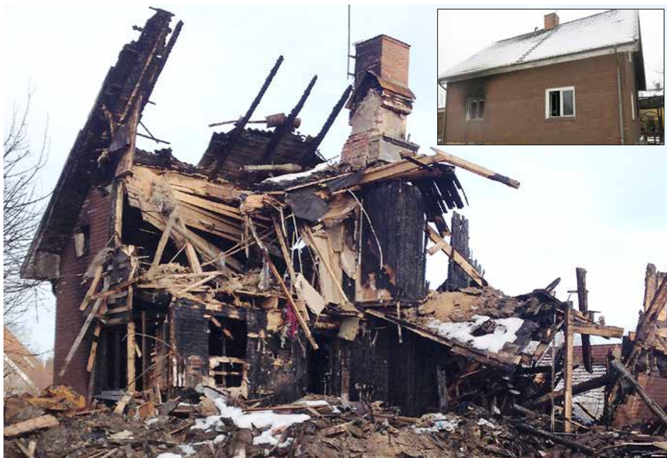
Villan klarade sig hyggligt (infällda bilden) sedan två styrkor släckt branden. Efteråt genomfördes ventilering och flera kontroller med värmekamera. En stund efter att räddningssenheterna lämnat platsen började det brinna igen och villan blev totalförstörd.
