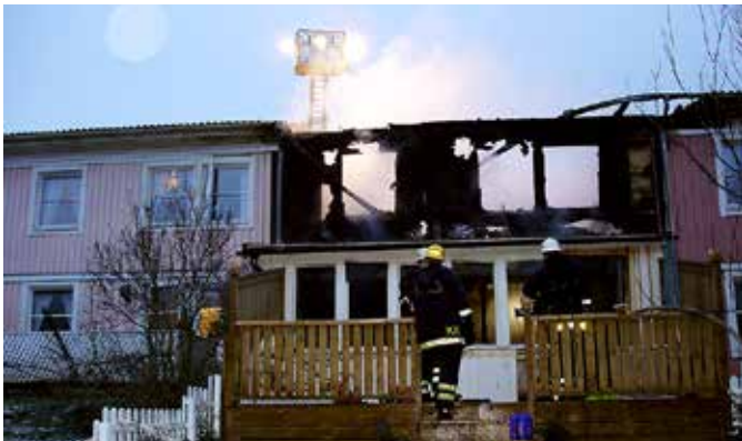
Brand i kedjehus/radhus är inte ovanliga och ofta sprids branden till fler boenden. Nu ska Revinge bygga en övningsanläggning för mer verklighetstrogen träning.
