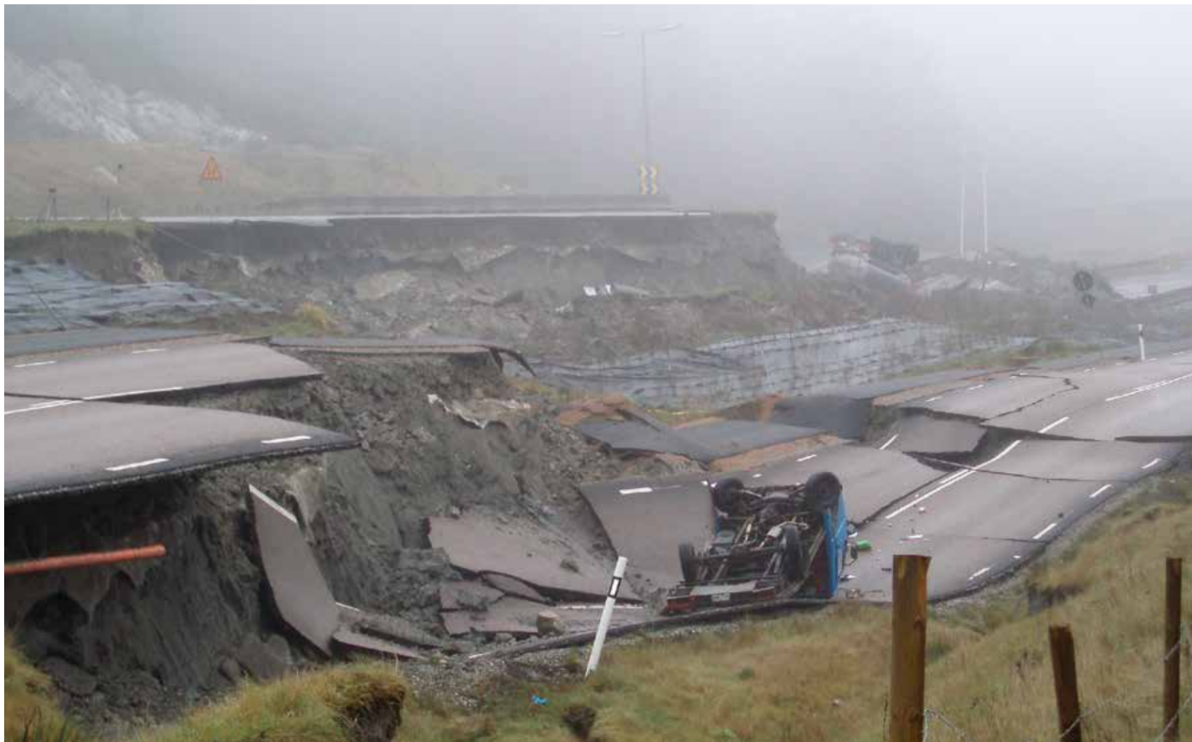
Efter skredet i Småröd 2006 ansåg Haverikommissionen att MSB borde utreda behovet av metodik för säkra och effektiva insatser i skredområden. En sådan har MSB nu tagit fram.
