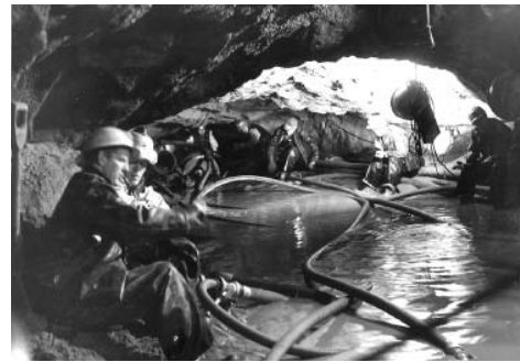
Ett viktigt moment var att läns-pumpa vattenmassorna i schaktet så att nivån sjönk. Men kapaciteten på pumparna var klen, bara några få kubikmeter per timme.
