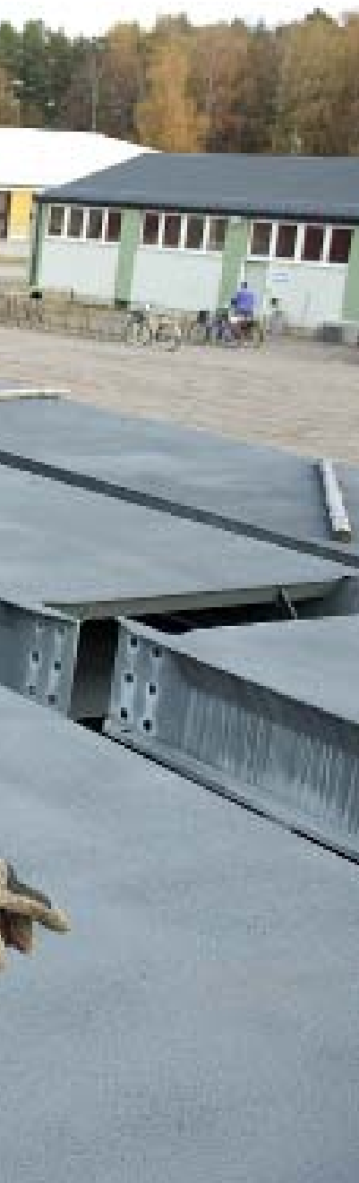
Det är beresta körbanepeltor. Den polska tillverkaren kunde inte borra med tillräcklig precision vilket fick göras i Malmö. Därefter är de ytbehandlade i Gävle och nu lagrade i Kristinehamn.
