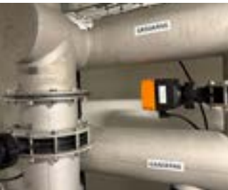
Ventilation, luftrening och övriga installationer ska klara ytterligare 30 års drift.
