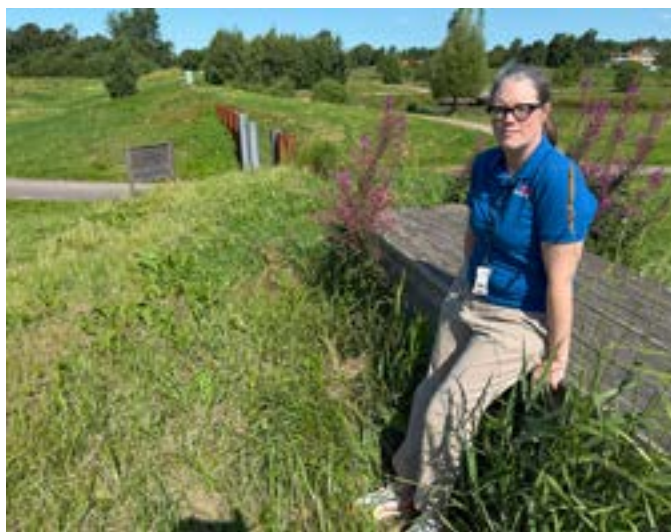
Den 1,2 kilometer långa vallen är en del av översvämningsskyddet i Getinge.
