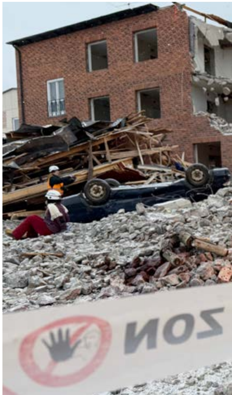
En byggnad i centrala Kumla som skulle rivas blev ett perfekt objekt för övningen under rasmassor.
