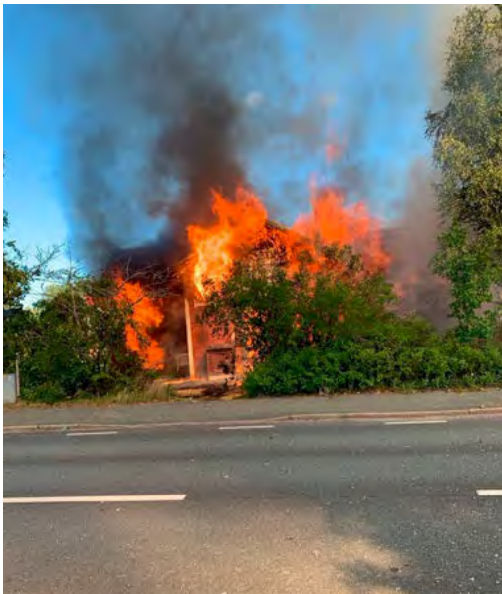
Den kraftiga explosionen skapade ett övertryck i källaren och bröt upp bjälklag och väggar i två våningsplan ovanför källaren.
