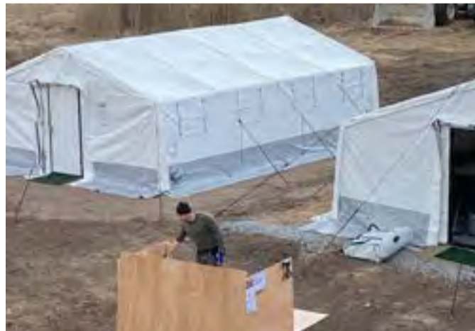
En mobil tältlösning byggs i väntan på att renoveringen av en fast anläggning för minröjare ska bli klar.
