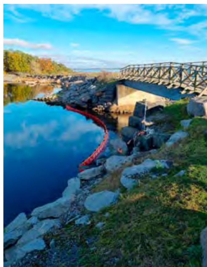
Räddningstjänsten vidtog förebyggande åtgärder som att lägga ut strandduk och länsor på flera platser. FOTO: RÄDDNINGSTJÄNSTEN
