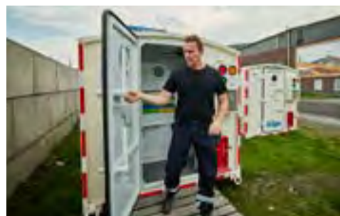
Så här ser räddningskammarna som finns nere i gruvan ut.
