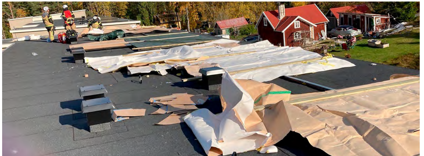
När räddningstjänsten täckte över solcellspanelerna med presenningar och pappskivor slocknade branden.
