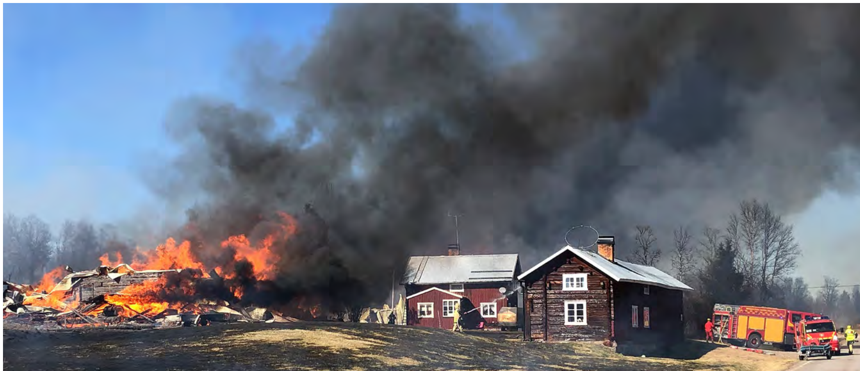
Det eldades gräs och löv i en tunna. Elden spred sig till en omfattande brand med nio nedbrunna fastigheter.
