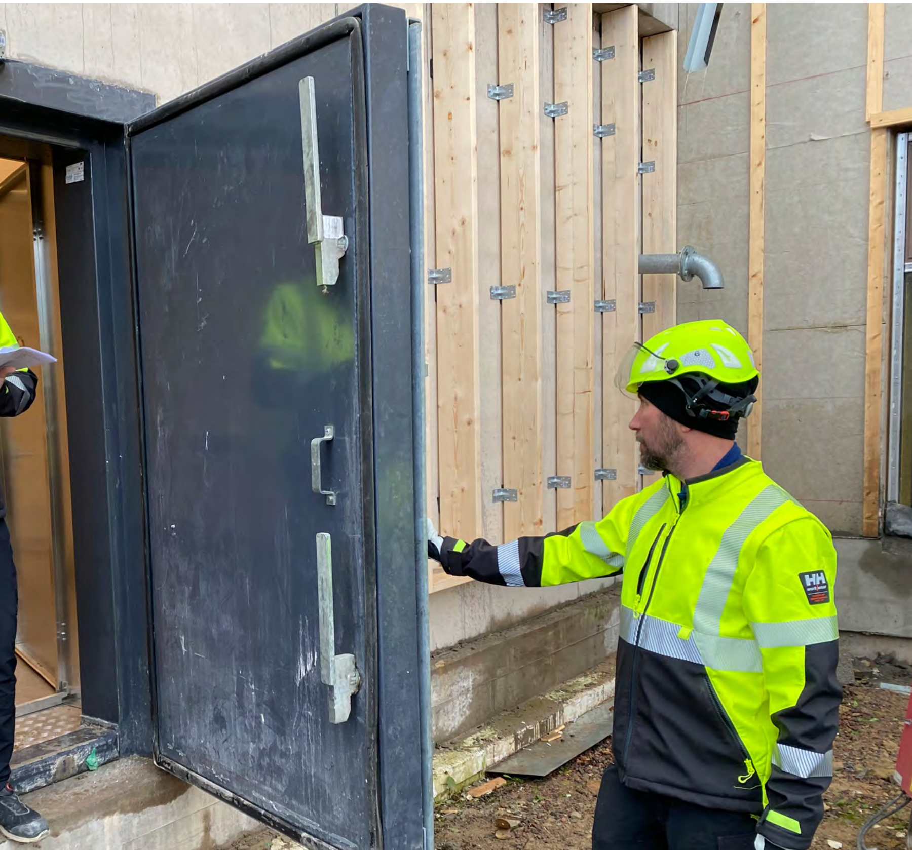
får göra slutbesiktningar av skyddsrum. Till sin hjälp har han skyddsrumssakkunniga kollegan Peter Carman (i dörröppningen).
