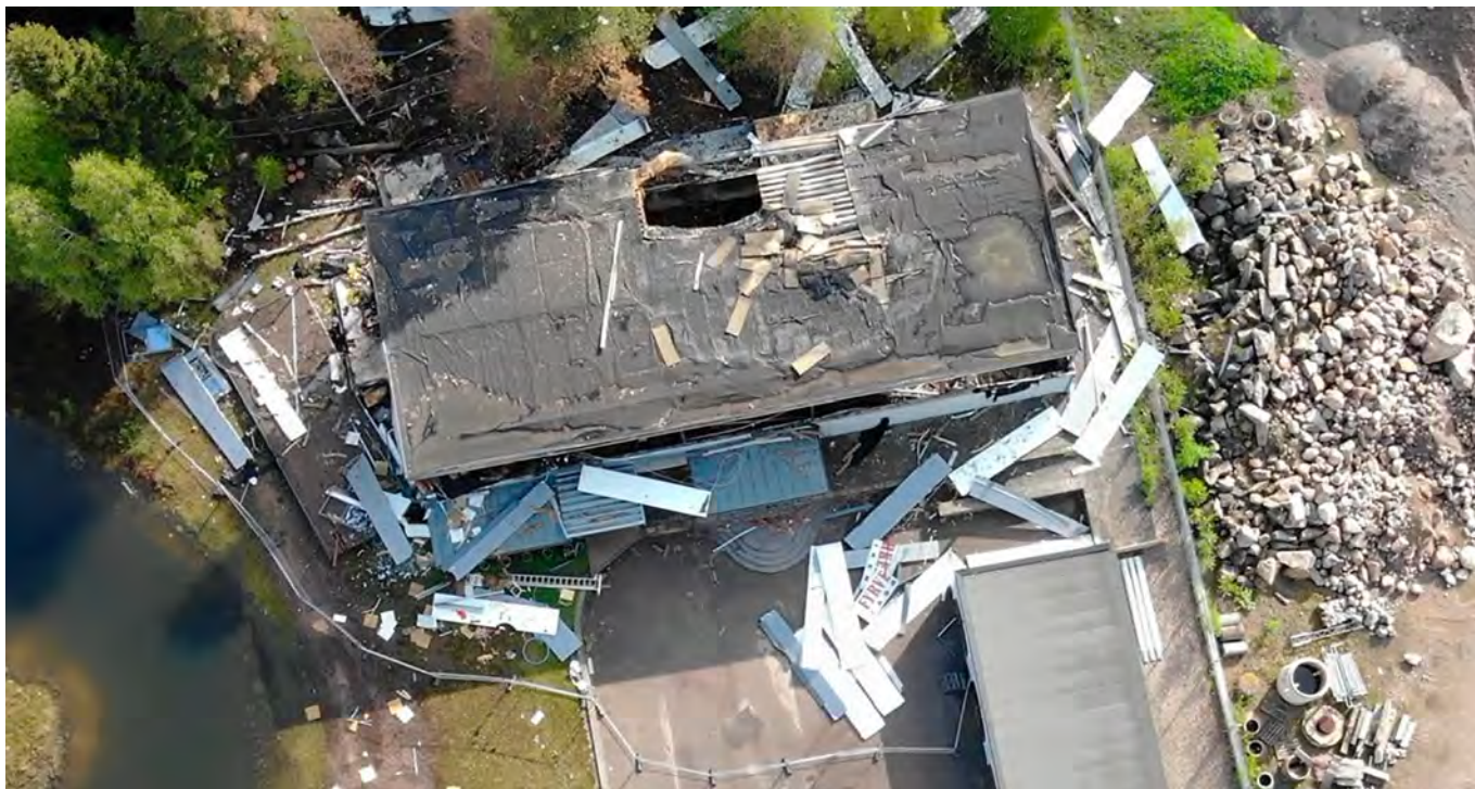
Fyrverkerilagret efter explosionen.
