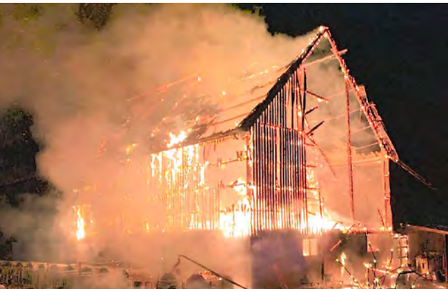
Spridning till intilliggande byggnad med 250 djur kunde förhin- dras, ur brandbyggnaden räddades 170 djur vid ladugårdsbran- den på Gotland.
