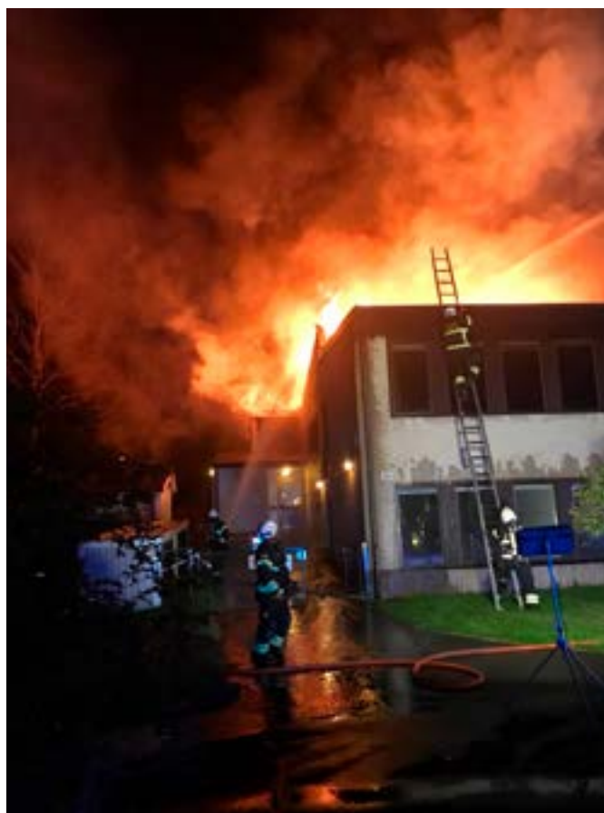
Trots att Ansgari kyrkan bara ligger några meter från den vältrafikerade E4:an, hade ingen sett branden. Lågorna var meterhöga när räddningstjänsten kom fram. FOTO: RÄDDNINGSTJÄNSTEN JÖNKÖPING
