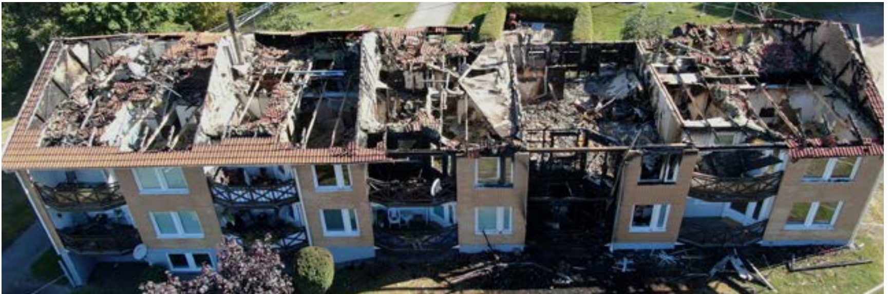
Brandstart i en lägenhet fick till följd att huset totalförstördes. Åter en byggnad där brandcellsgränser inte var tillräckliga.
