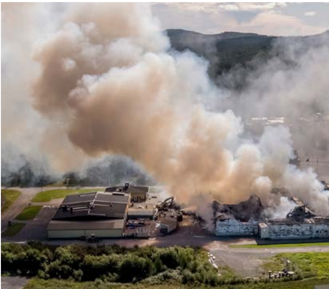
Branden slutade i en katastrof för Polarbröd, med totalförstörd fabrikslokal.
