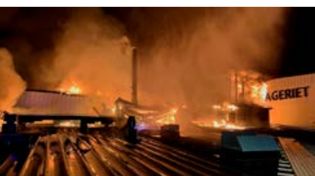
Midnatt, takkonstruktionen är intakt men branden har spridit sig upp till samtliga ventilationsutrymmen och ventilcentraler som står på taket.
