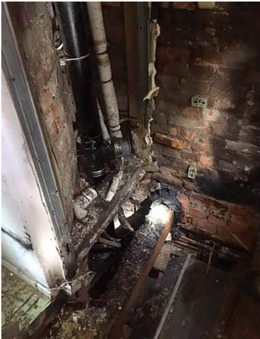
Under arbetet med branden i trossbotten gjordes flera små hål i golvet och trossbotten fylldes med Cafs-skum mellan golvreglarna, fack för fack. När temperaturen minskade påbörjades öppning och friläggning av schakt och delar av golv.
