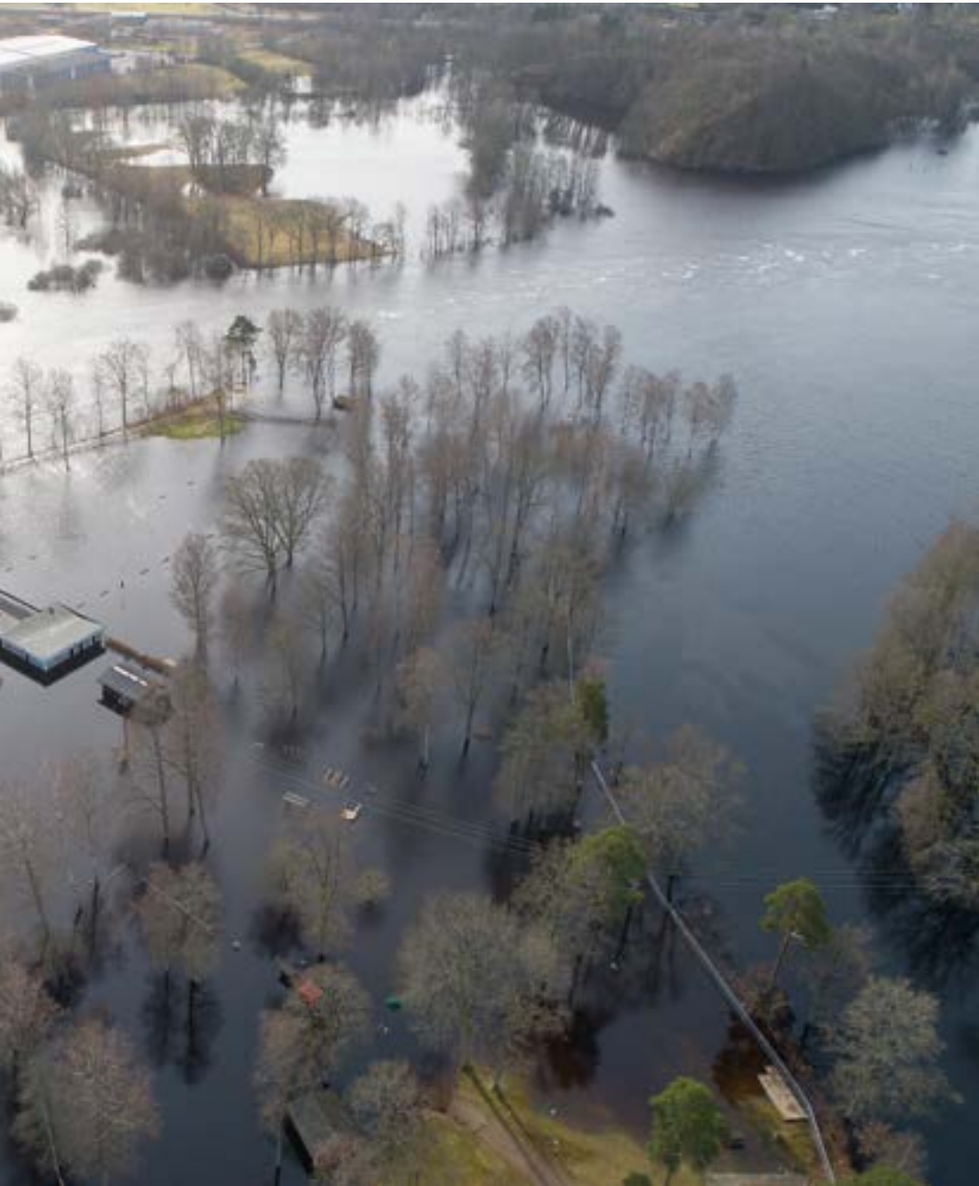
... när det varnades för 50-årsflöden i Lagan och Nissan. Någon kilometer nedan kraftstationen i Knäred, där camping, närmast i bild, är översvämmad och utomhusbassängen försvunnen under vattnet. I bakgrunden
