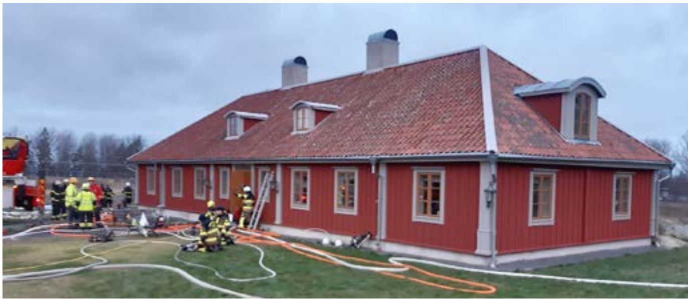
Branden hade börjat i området kring öppna spisen och spreds in i byggnadskonstruktionen. 1700-talsbyggnaden fick stora skador och insatsen blev omfattande.
