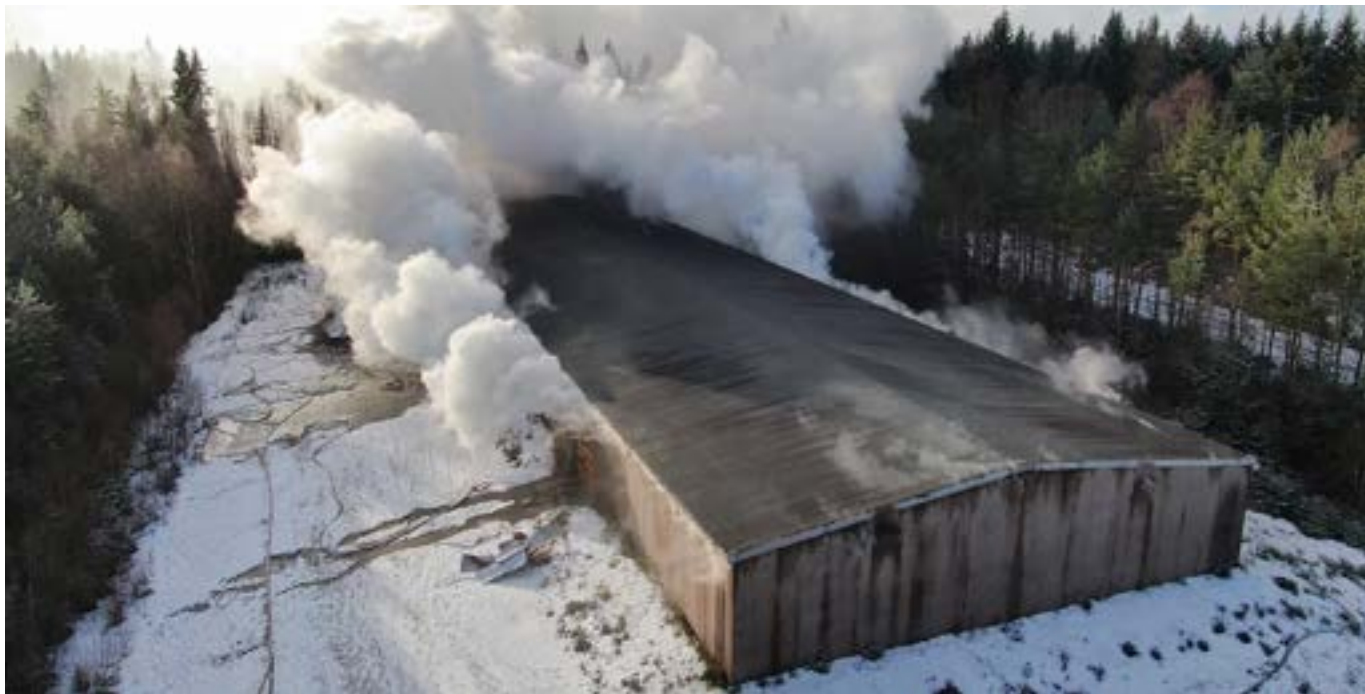
Branden gick inte att släcka med konventionella metoder. Då valde räddningstjänsten att kapsla in det stora avfallslagret på 2 300 kvadratmeter för att kväva branden. Det gick åt 43,5 kubikmeter betong.
