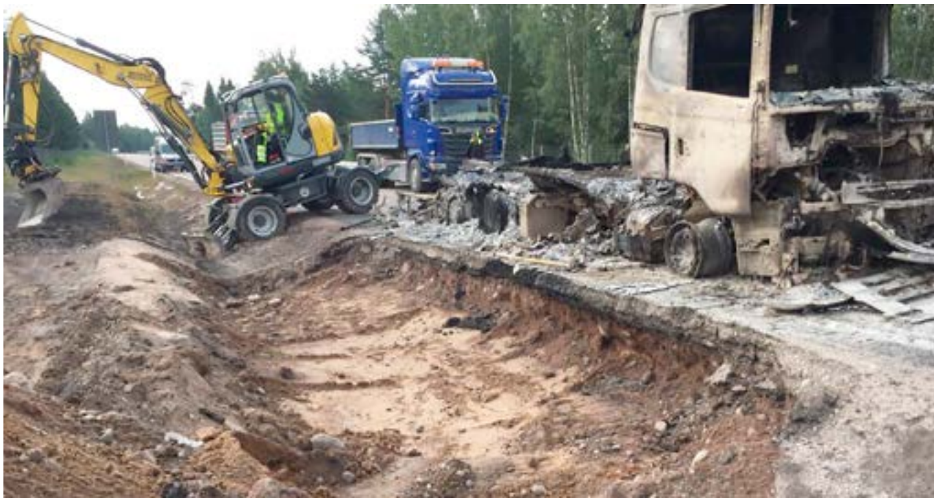
Räddningsledarens beslut blev att inte försöka släcka branden i lastbilen, utan att minimera skadeeffekten på miljön. När branden avtagit kunde schaktningsarbete inledas. Här hyvlas översta marklagret av för att få en bättre bild av eventuell spridning ned i mark.
